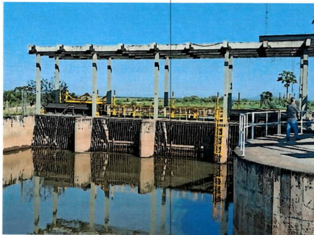
Foto 2: Gradeamento da captação.
