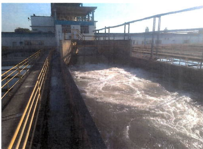
Foto 20: Entrada de água para início do tratamento.
