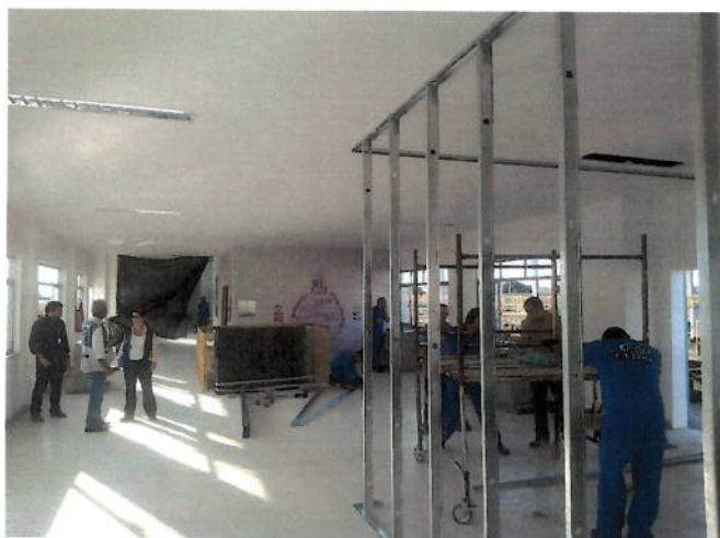
Foto 30: galeria de filtros em obras (parte superior).
