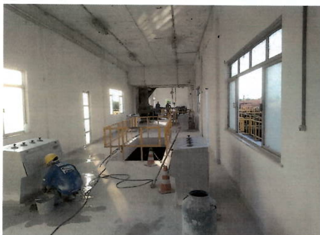
Foto 32: galeria de filtros em obras (parte superior).
