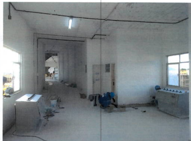
Foto 31: galeria de filtros em obras (parte superior).
