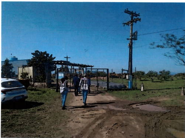
Foto 1: Entrada unidade de captação. Área devidamente cercada, entretanto, sem placa de identificação.
