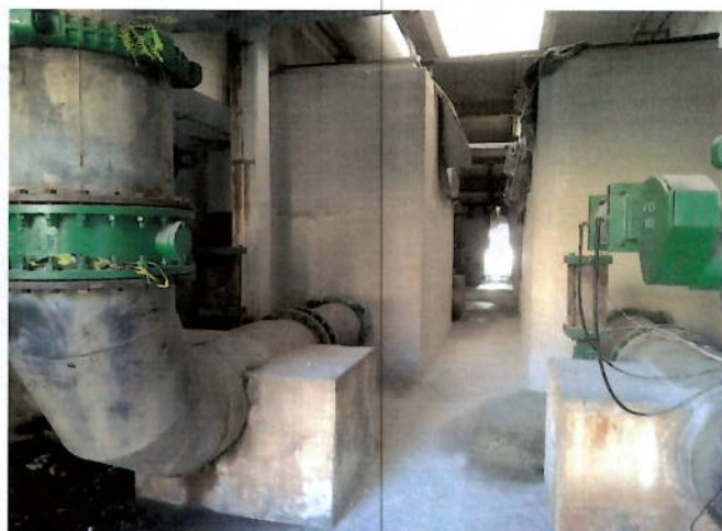
Foto 33: galeria de filtros em obras (parte inferior).
