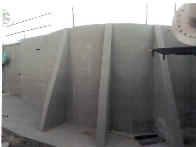
Foto 40: Reforma realizada na curva do tanque de contato.
