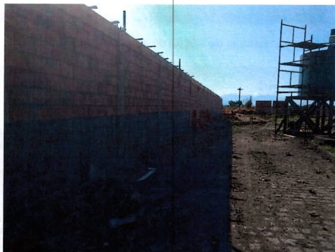
Foto 12: Realização de obra de cercamento.
