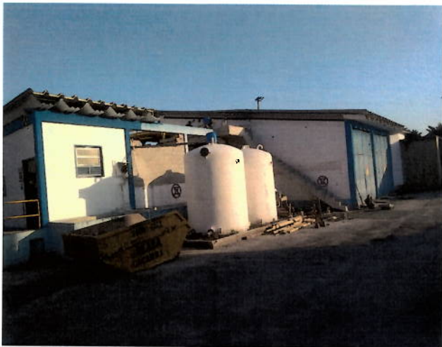
Foto 38: Prédio do sistema de cloração (em obras).
