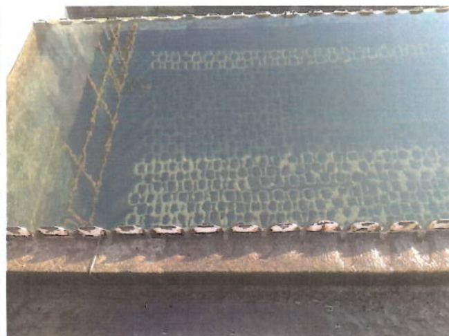
Foto 27: Módulo de colméia dos decantadores.
